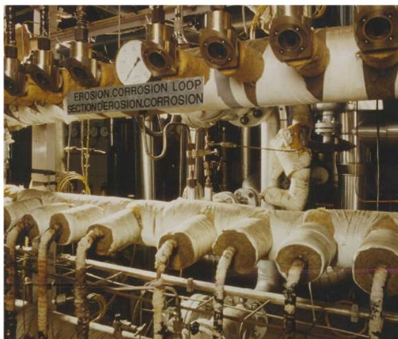
Afb. 12 De stoomstraalapparatuur, gebruikt bij het erosie-corrosie door natte stoom
